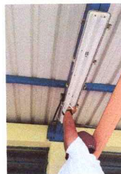
Foto 6: Sustitucion de Lamparas Led.
