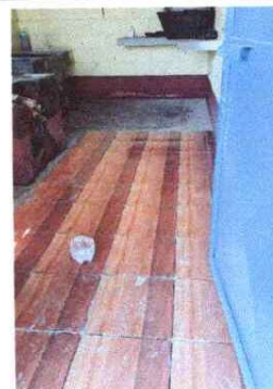
Foto 4: Sustitución de piso de cemento liquido por piso cerámico en cocina, módulo 1
