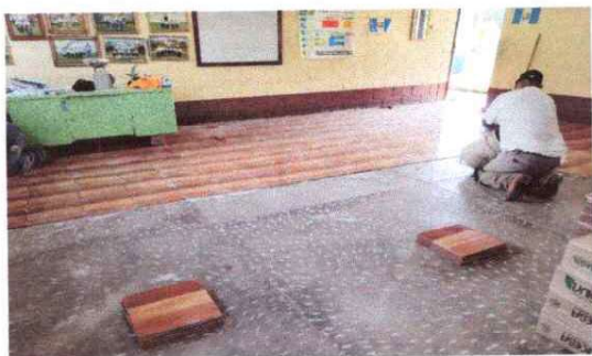
Foto 3: Sustitución de piso de cemento liquido por piso cerámico en aulas, módulo 1
