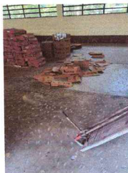
Foto 5: Sustitución de piso de cemento liquido por piso cerámico en aulas, módulo 2
